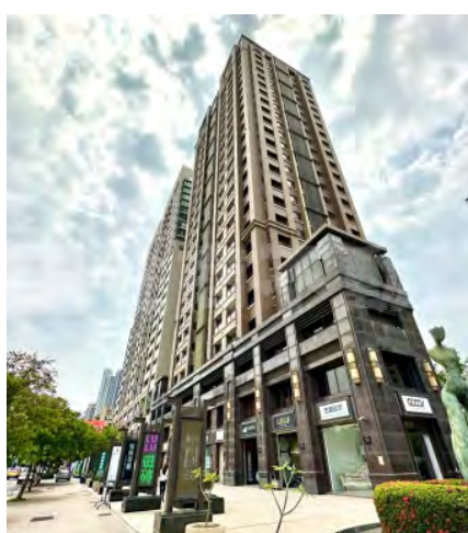
台中 聚合發建設 - 中港 THE ONE
