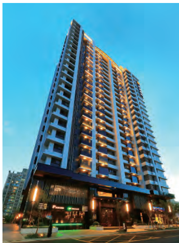
高雄 - 龍騰建設 鑫高鐵
